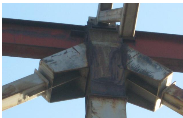
Рисунок А.25 – Раскосная связь со сдвиговым энергопоглотителем
